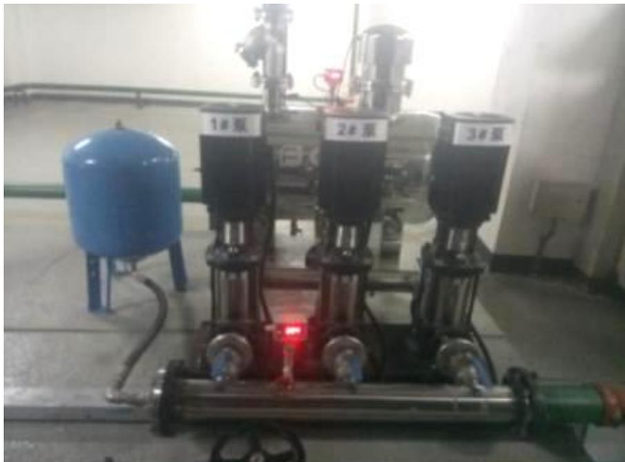
卡森卫星城二次恒压供水，采用智能电机与系统一体，根据居民用水高低峰值，自行调节恒压供水，改变原有遇到用水高峰期时水压不足需人家增开加压泵的情况。实现了无人值守恒压供水。电机采用4KW-3000r/min，整套系统不但满足的工况要求，整套系统占用场地缩小，实现无人值守，节能方面也比原套旧供水系统节能率达24.17%。
